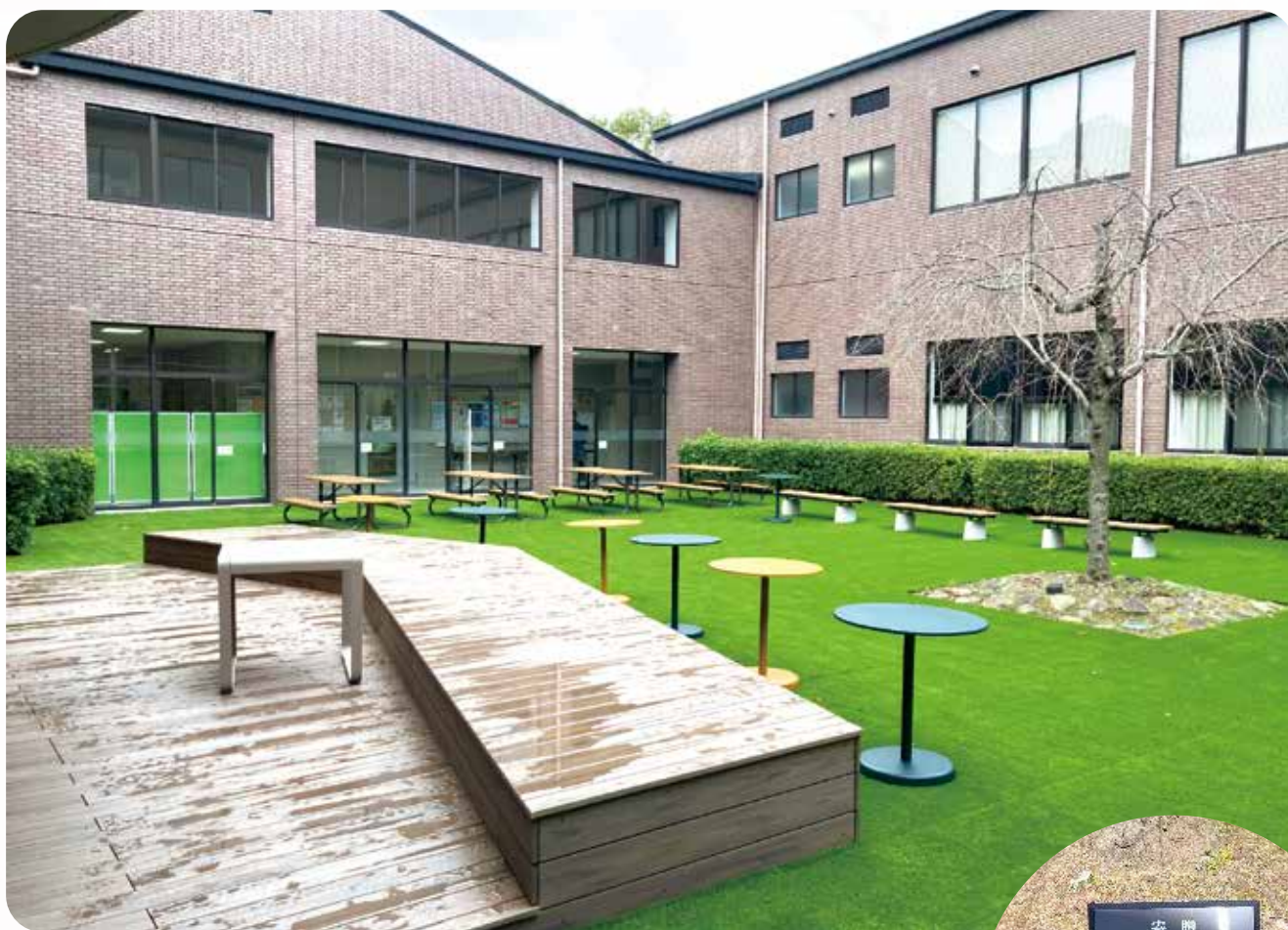
改修された2号館中庭
